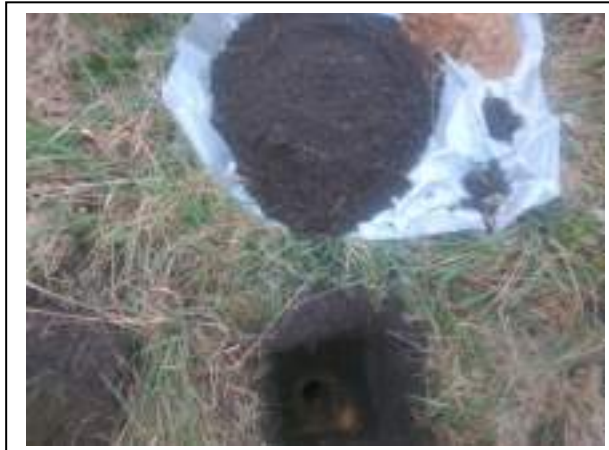
Foto 8. Opgegraven en gezeefd materiaal asbestinspectiegat C08
