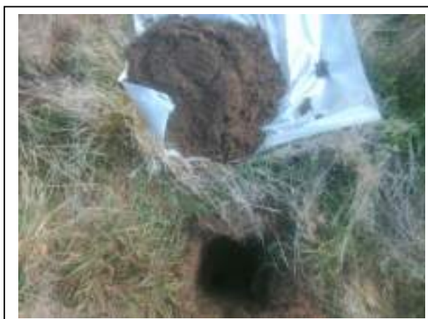
Foto 10. Opgegraven en gezeefd materiaal asbestinspectiegat D02
